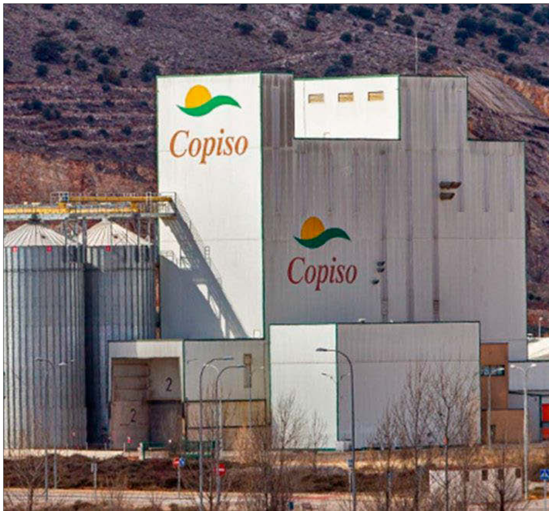
Planta de Copiso en el polígono industrial de Valcorba. MARIO TEJEDOR
